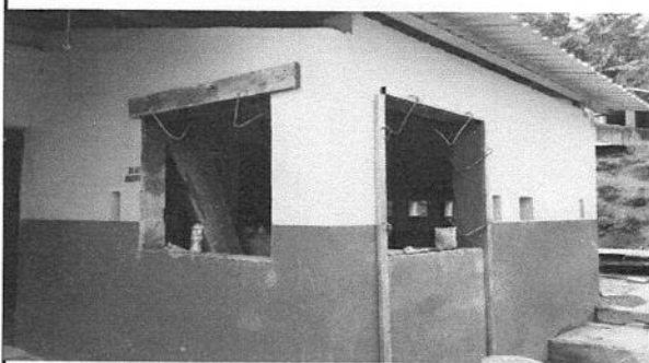
Foto 6: Cocina, trabajando en la sustitcion de ventanas en el area de la cocina.
