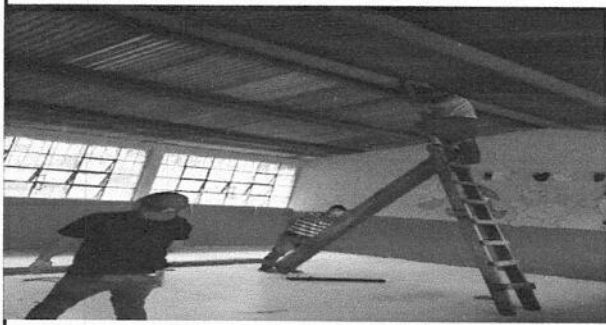
Foto 3: Aulas, trabajando en la repacion del sistema electrico.
