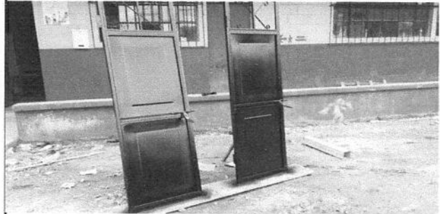
Foto 2: Baños, sustitucion de puertas en el area de servicios sanitarios de los estudiantes.
